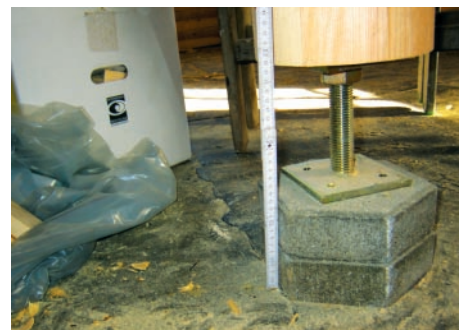
Selbst bei einer relativen Holzfeuchte von 20% gilt es, fast 5 cm Setzung zu berücksichtigen.
