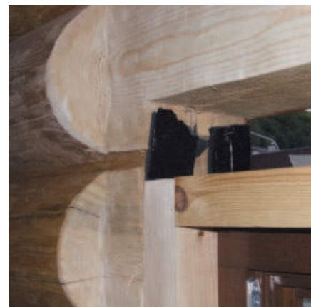
Fensterleiste mit silikoniertem Dichtband, damit der Block gut rutschen kann.
