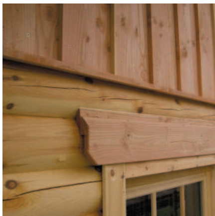
Beim Wetterbrett sollte genügend Sackraum zur Verfügung stehen. Hierbei ist das gleiche Setzmaß wie oberhalb des Fensters einzuhalten.
